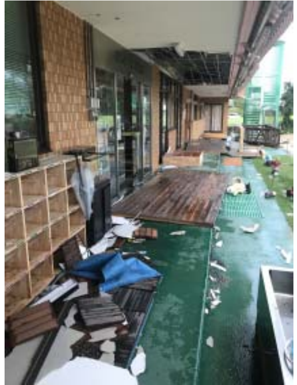
幼児棟廊下の様子 2
