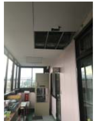
2階廊下の様子 2
