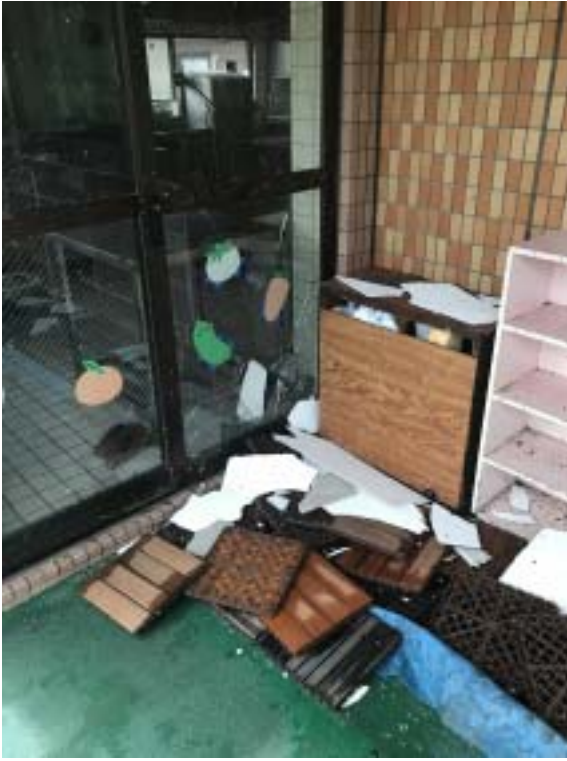
幼児棟廊下の様子 1
